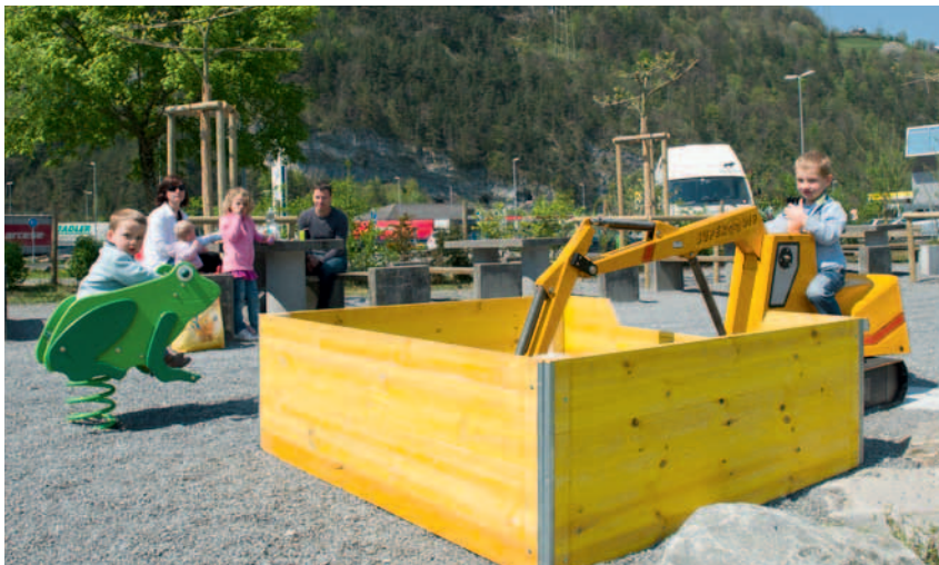
Gebaut wird nicht nur auf der Autobahn. Auch auf dem neu erstellten Spielplatz neben dem Hauptgebäude läuft der Bagger auf Hochtouren.
